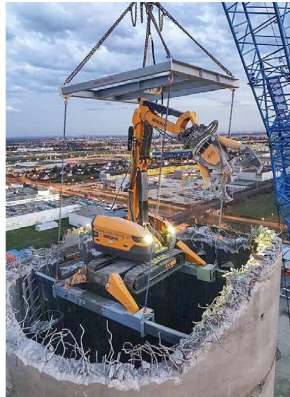
Wiederverwerten statt verschrotten (oben): Das Sozialunternehmen Baukarussell baute im Dusia-Stadion 1.100 Tribünenstühle aus und vermittelte sie an neue Besitzer. Schweres Gerät (rechts): Die Abbruchprofis von Zöchling rücken bei hohen Gebäuden mit einem „fliegenden“ Bagger an, der am Kranseil hängt
