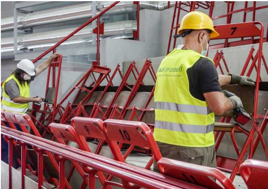
Wiederverwerten statt verschrotten (oben): Das Sozialunternehmen Baukarussell baute im Dusia-Stadion 1.100 Tribünenstühle aus und vermittelte sie an neue Besitzer. Schweres Gerät (rechts): Die Abbruchprofis von Zöchling rücken bei hohen Gebäuden mit einem „fliegenden“ Bagger an, der am Kranseil hängt
